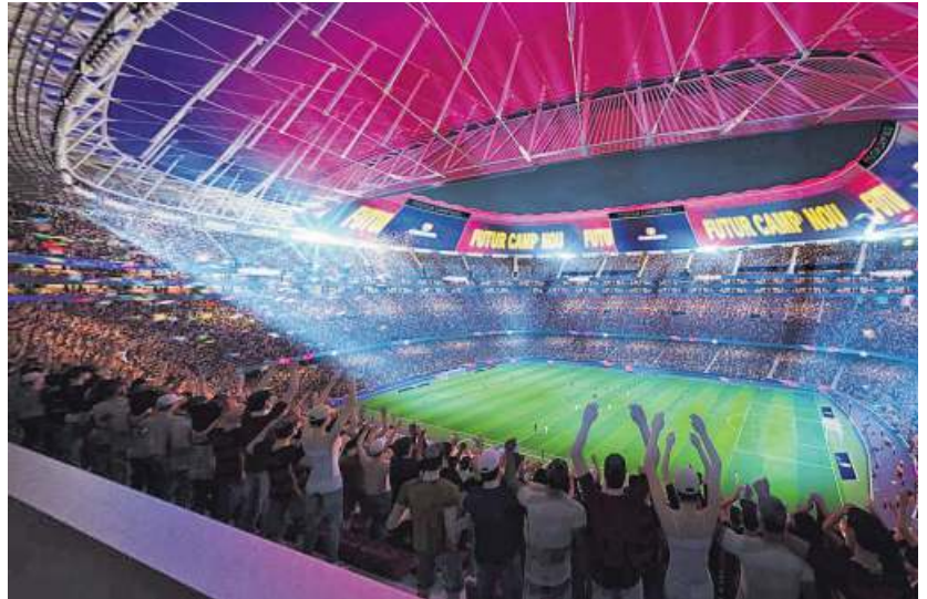
Recreación de la futura cubierta que protegerá las instalaciones deportivas, con un anillo central.
