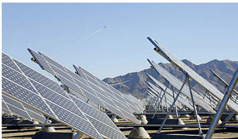
Placas solares. eE
